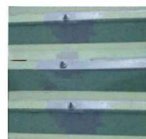
施工前の屋根(遮熱塗装前)
