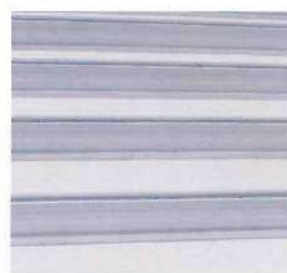
施工後の屋根(遮熱塗装後)
