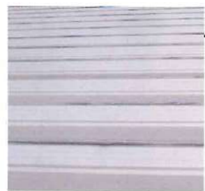
施工前の屋根(遮熱塗装前)
